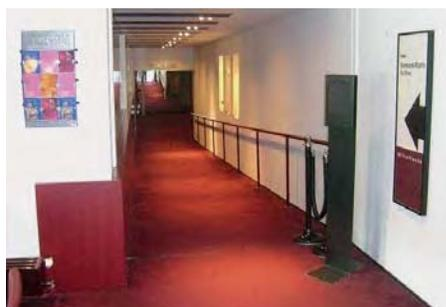
La présence de mains courantes préhensibles et repérables (contrastées) peut être utile le long du cheminement (selon la configuration du terrain) et nécessaire en cas de changement de niveau (franchissement de ressauts importants ou de marches, de rampes...).
